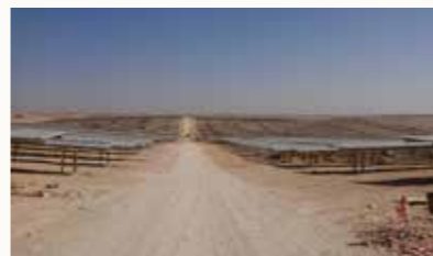
ムワッカルに建設中の太陽光発電所。
