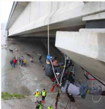
モロッコの橋梁での実務訓練。
