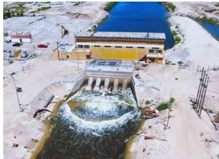
イラク全土の中で、農業が重要な地域において農業生産性を向上させるための円借款「灌漑セクターローン」で建設された灌漑施設。
