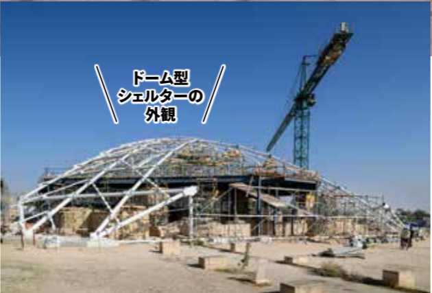
シェルターは55×45mの大きさで、高さは約13m。
