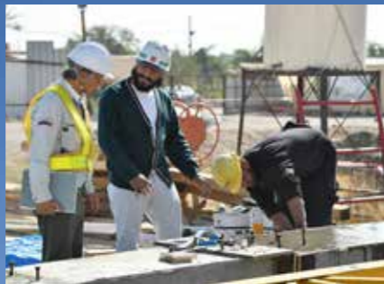
建設現場では日本人とパレスチナ人合わせて約25人が働く。現場では日本のように標識の掲示なども徹底している。安全文化を輸出・定着させることも重要なミッションだ。
